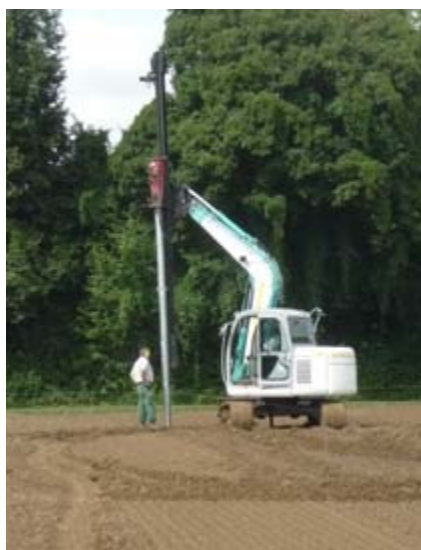
Abb. 2: Rammen der Stützen für die Modultische
